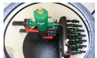
Arqueta para colectores con separador
